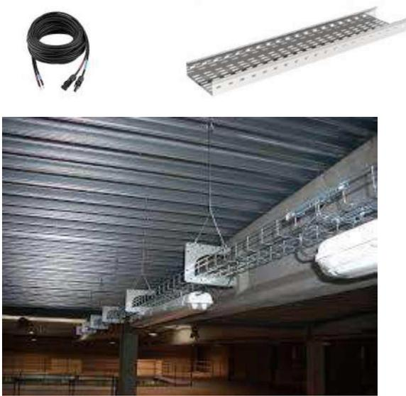
Les chemins de câbles contenant les câbles électriques seront fixés sur la structure métallique sous les modules photovoltaïques. Ces éléments ne sont pas en contact avec les eaux de pluie collectée. A ce titre, ils ne présentent pas de risque particulier.
