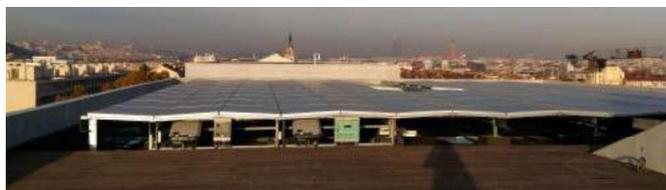
Figure 39 : Exemple de structure reprenant les variations de niveau et d'inclinaison avec fixation dans le sol par des plots béton (source : TRANSENERGIE)
