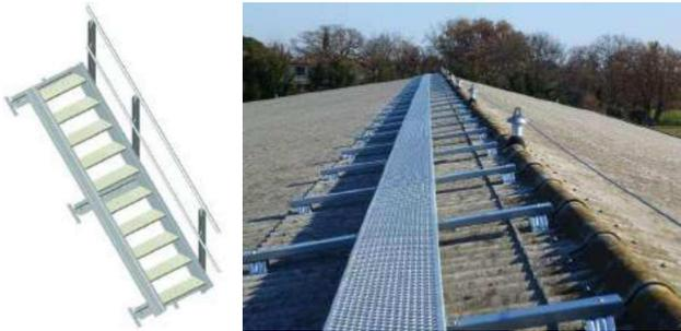
Les eaux qui passeront sur ces chemins de circulation seront collectées par les cheneaux situés en dessous. Les chemins de circulation sont indiqués sur le plan de calepinage (Figure 4).
