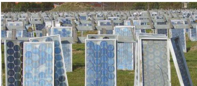
Le démantèlement d'une installation photovoltaïque consiste à déposer tous les éléments constitutifs du système, depuis les modules jusqu'aux câbles électriques en passant par les structures support. Une installation peut être démontée soit en totalité pour tri et recyclage, soit partiellement.
